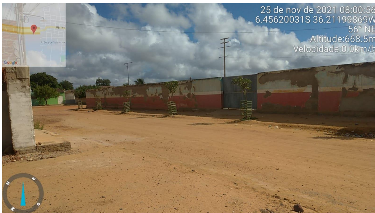
Figura 3: Todo o reboco e chapisco das paredes das fachadas serão removidos
