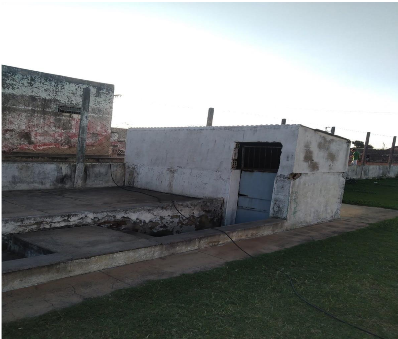
Figura 8: Local em que serão executadas as lajes pré-fabricadas
