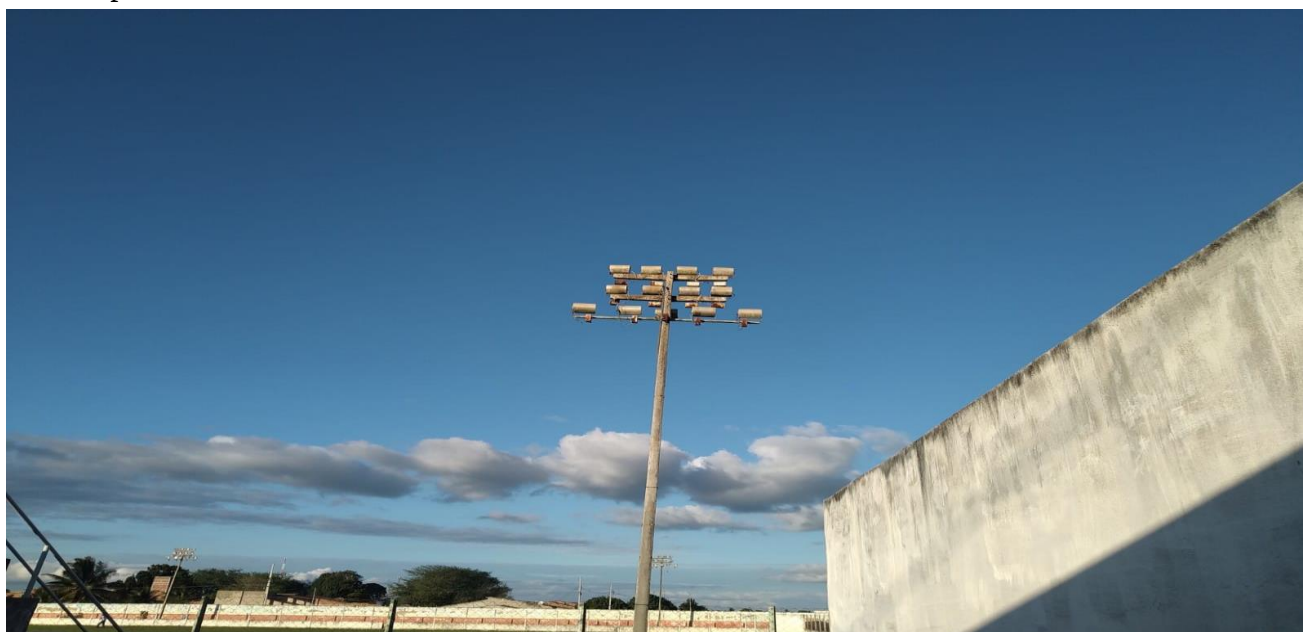
Figura 9: Poste de concreto para iluminação do estádio
