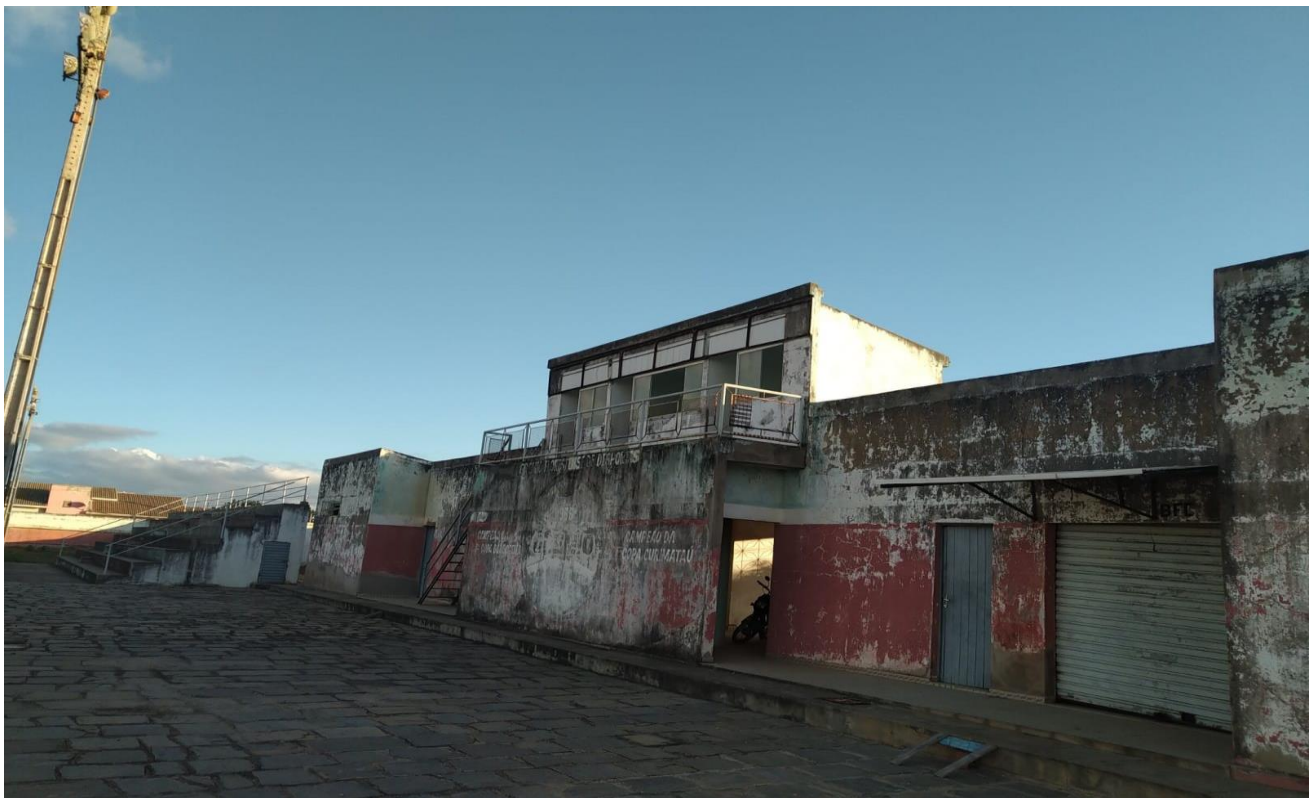
Figura 7: Cobertura da cantina
