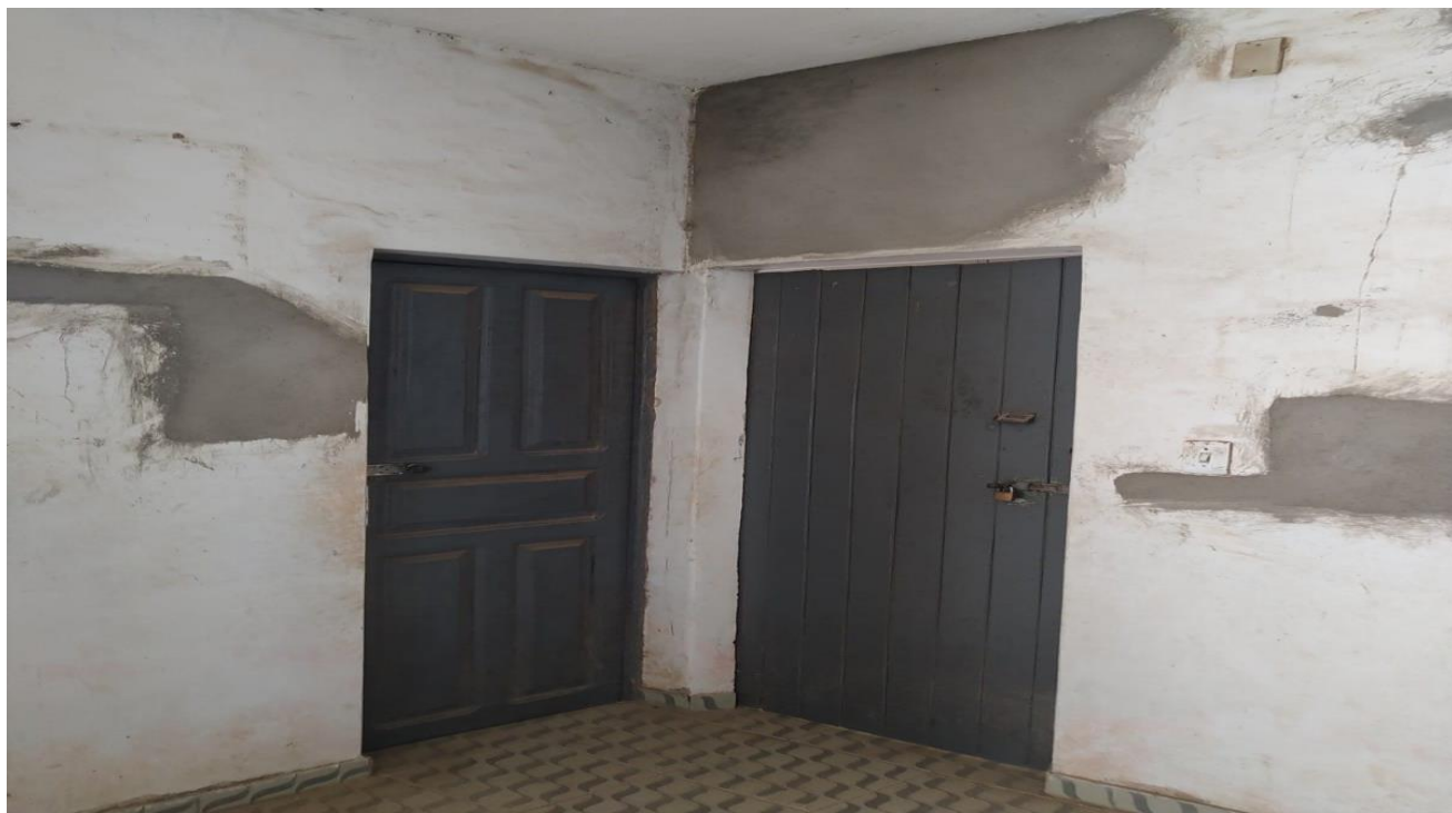
Figura 1: Quase todas as portas serão removidas
