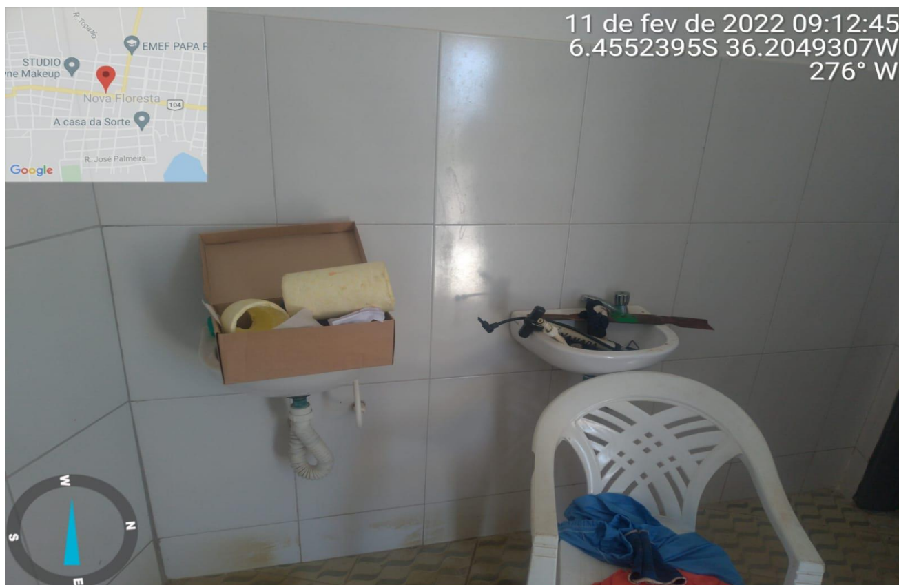
Figura 10: Lavatórios a serem removidos
