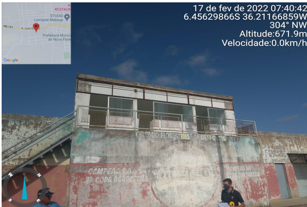
Figura 5: Local de instalação de cobertura metálica - cabines
