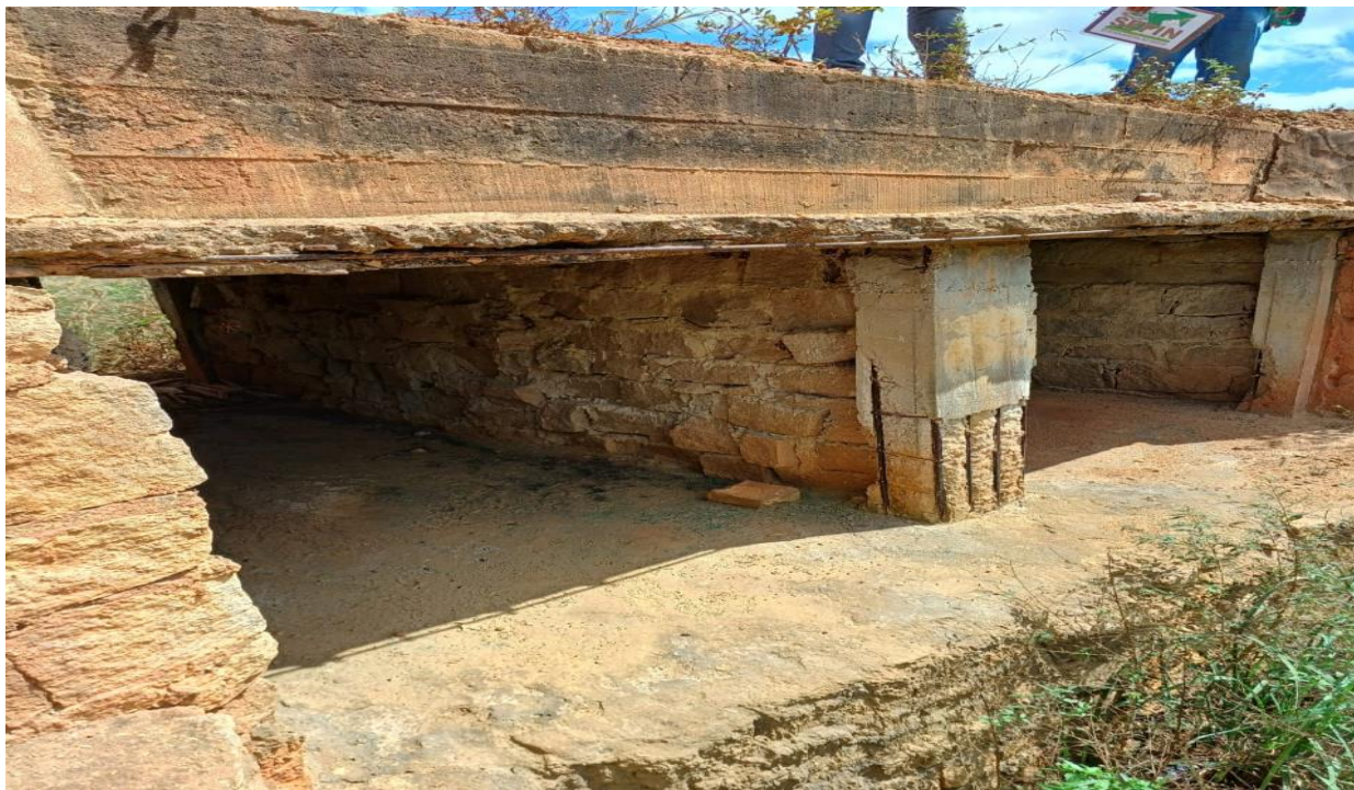
Figura 5: Vertedouro do Açude do Jacaré - A ser restaurado
