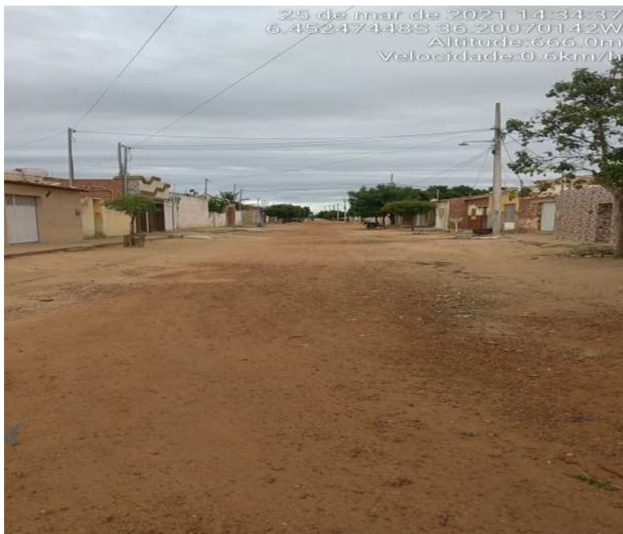
Figura 2: Início do trecho a ser pavimentado.
