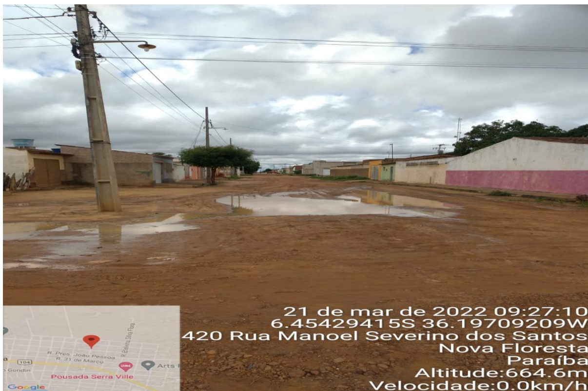
Figura 7: Rua Antônio Maximínio
