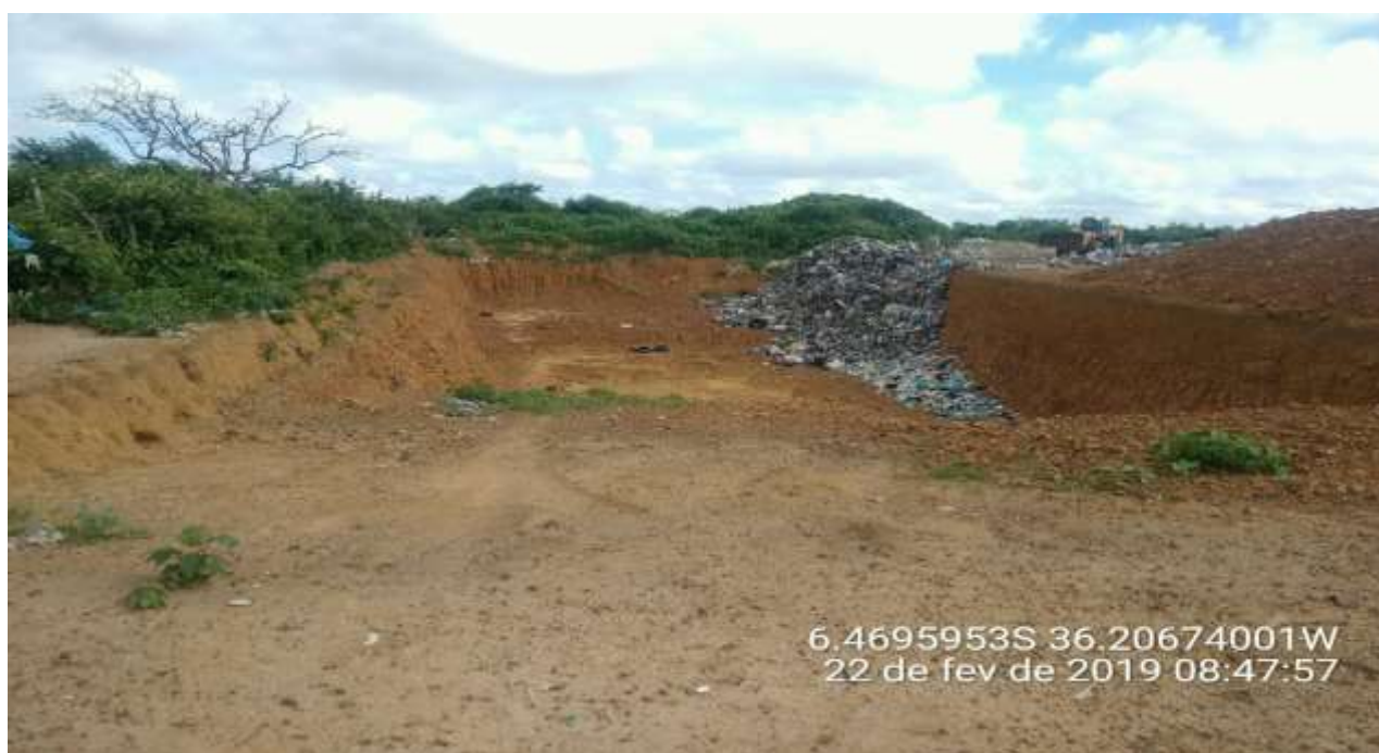
Figura 3: Vala escavada para depósito de lixo
