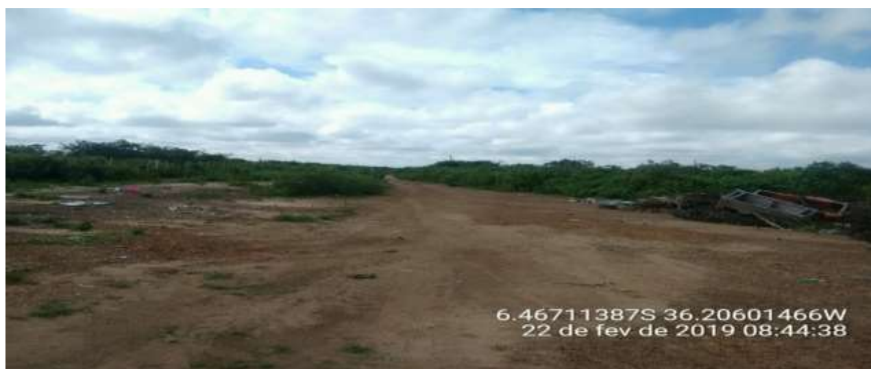
Figura 1: Estrada de acesso no terreno do lixão
