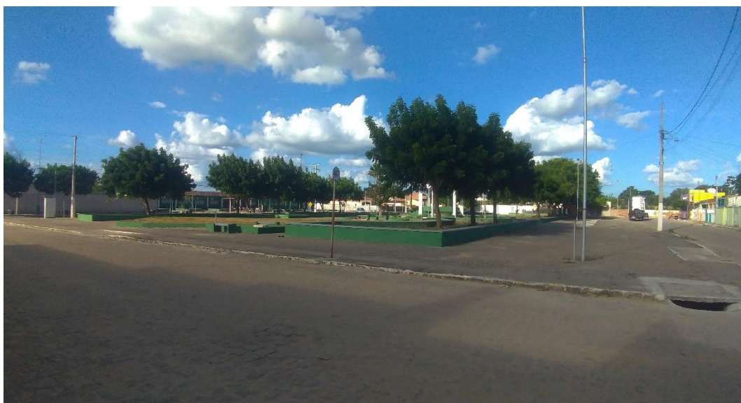
Figura 5: Serão instalados 28 postes para melhor iluminação da praça
