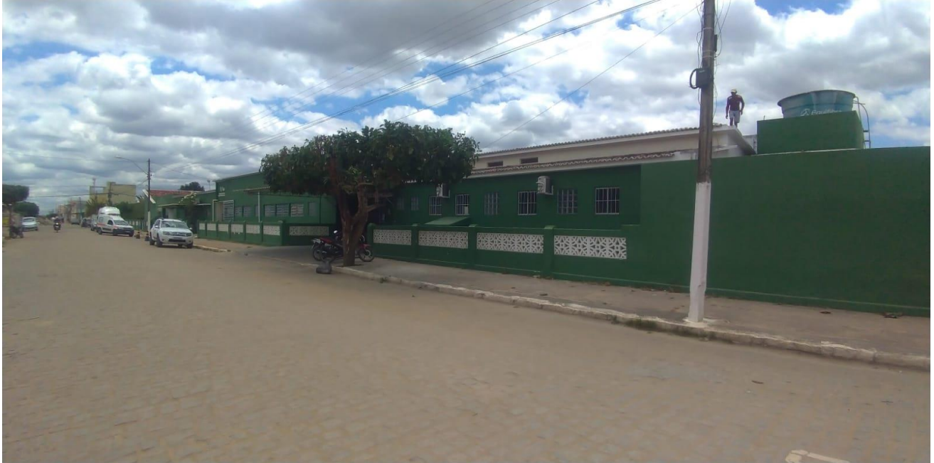
Figura 2: Fachada do Prédio
