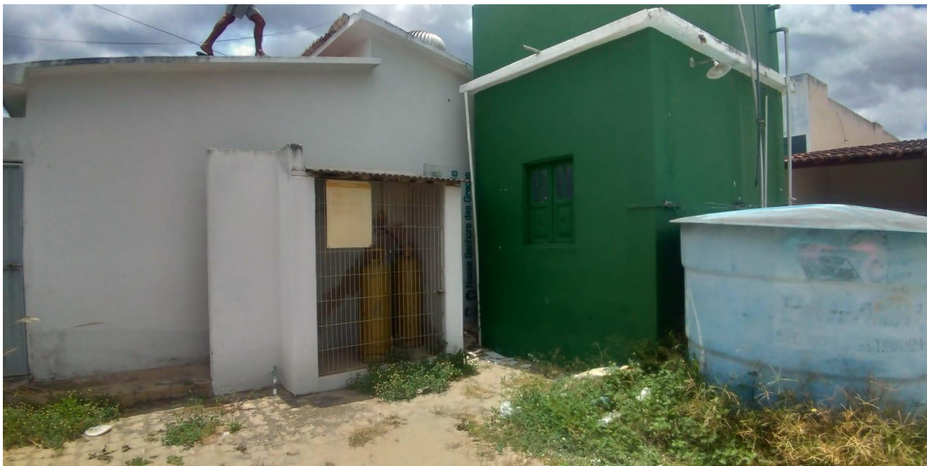
Figura 4: Local da Ampliação
