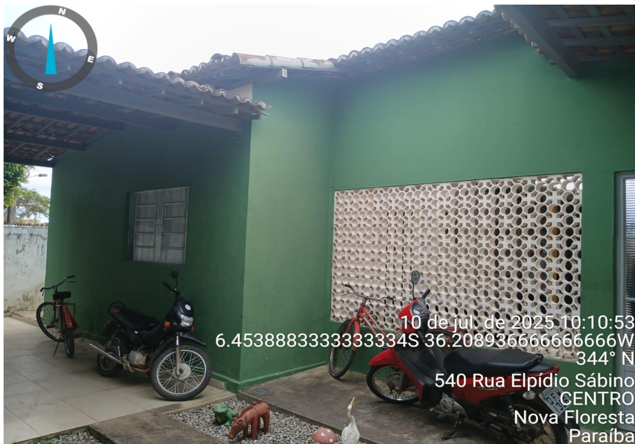
Figura 7: Cobertura no interior da creche
