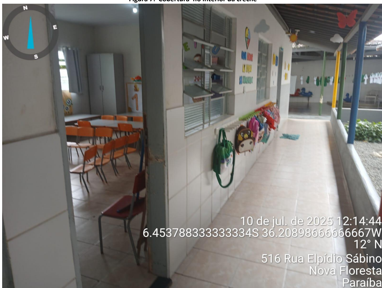
Figura 8: Corredor de acesso as salas de aulas, do lado esquerdo
