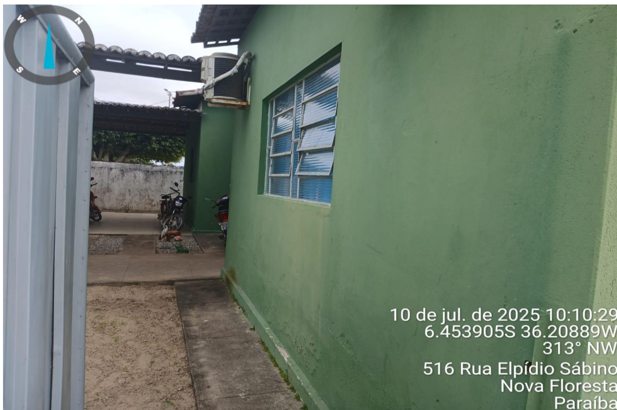
Figura 11: Acesso ao espaço aberto do lado esquerdo
