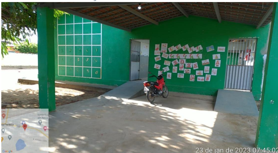
Figura 3: Entrada da edificação
